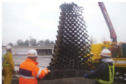
ハニカム構造は容易に撤去可能で、残った碎石は、その後の簡易舗装における路盤材として使えます。
