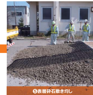
⑤表層碎石敷き均し
