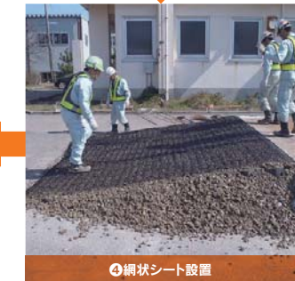
④網状シート設置
