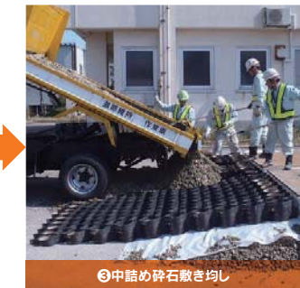
③中詰め碎石敷き均し
