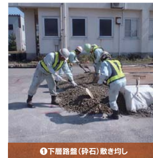
①下層路盤(碎石)敷き均し
